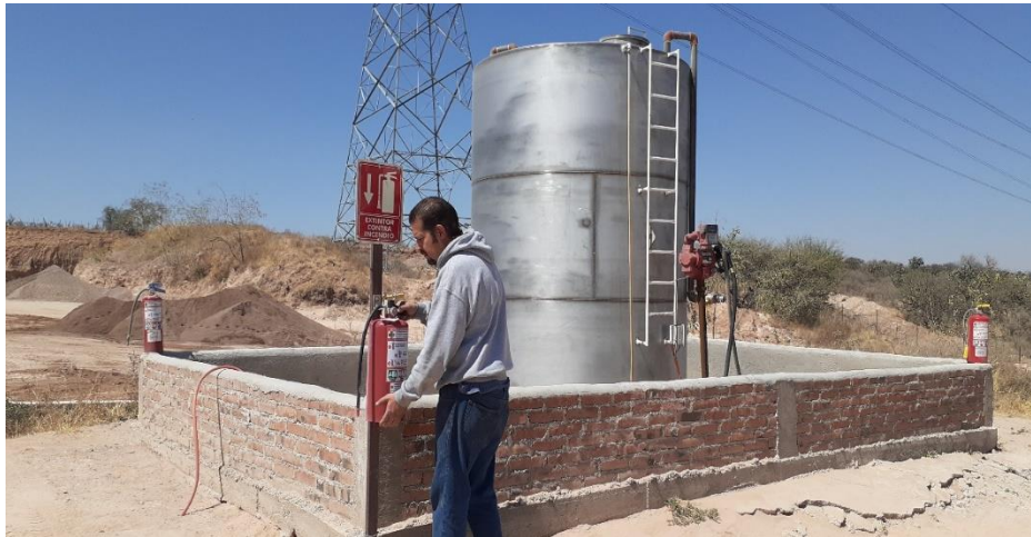
Ilustración 9 Instalación de extintores propio
