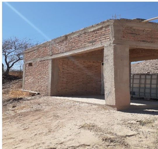
Ilustración 14 Como se encuentran las instalaciones Imagen propia
