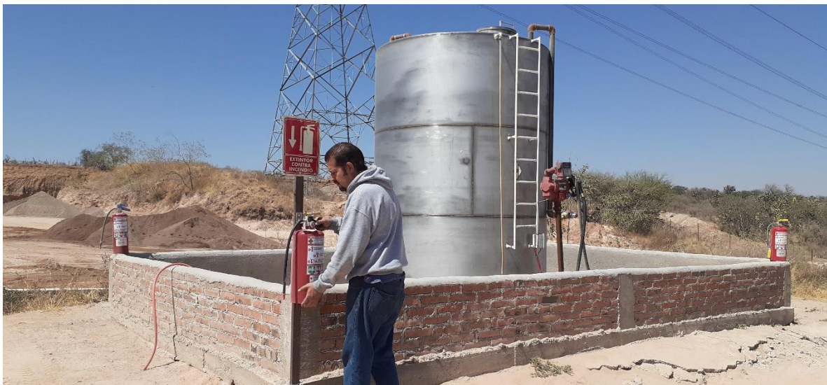
Ilustración 16 Colocación de extintores
