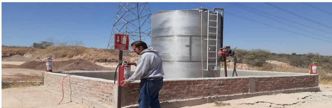
Ilustración 3 Colocación de extintores Propio
